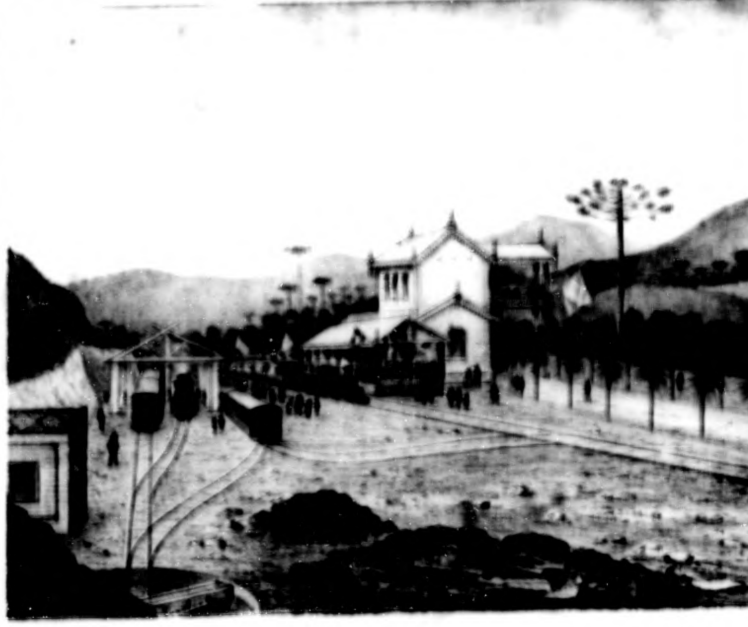
ESTACAO DE POÇOS DE CALDAS
