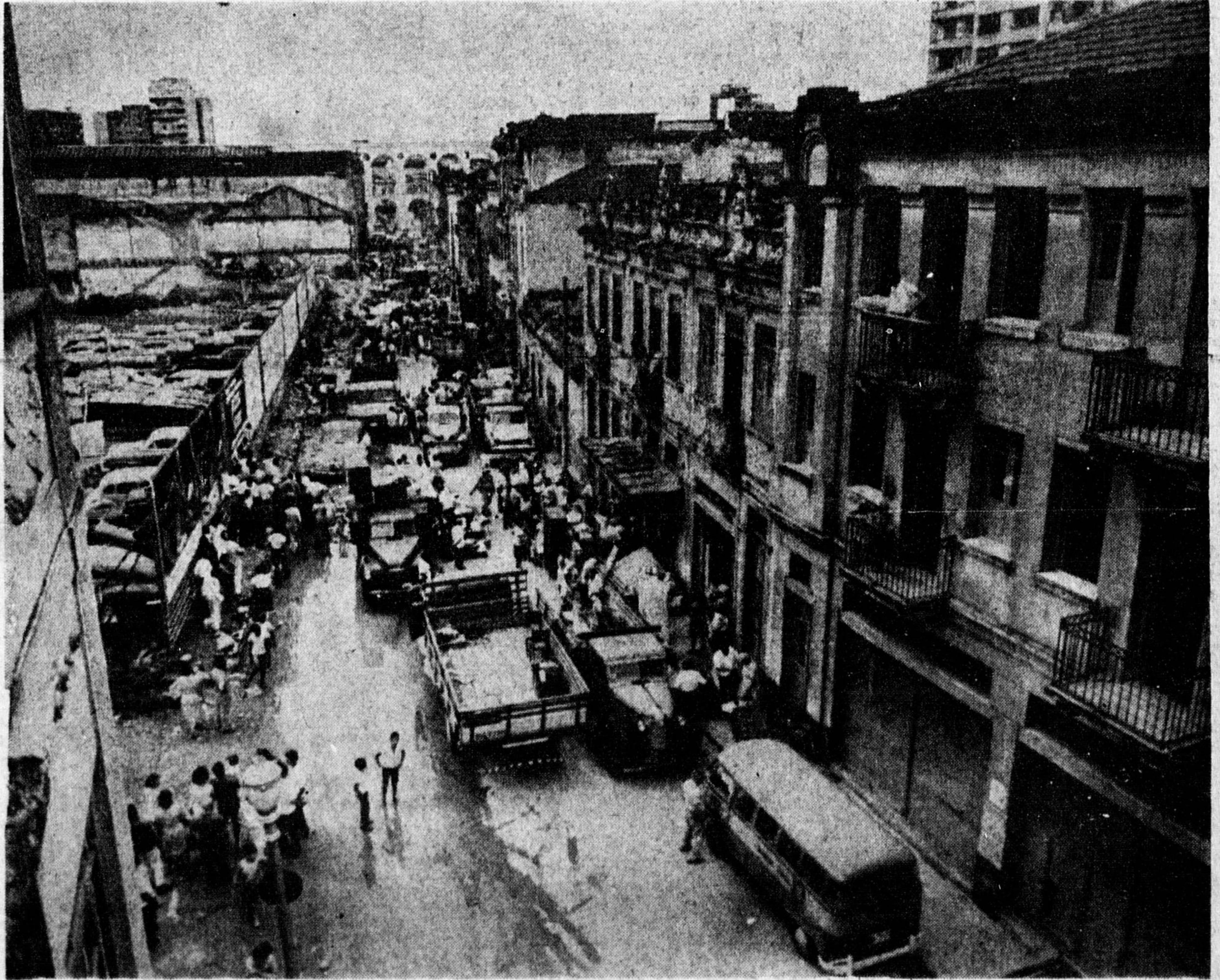
Durante toda a manhã de ontem, centenas de moradores da Rua dos Arcos se empenharam na faina de remoção de seus móveis e pertences (foto), uma vez que o Governo do Estado decidiu pôr abaixo todos os prédios condenados daquele trecho da antiga Lapa, onde na véspera ruíram dois casarões. Enquanto os moradores faziam a mudança coletiva, os bombeiros prosseguiram na escavação dos escombros — de onde já foram retirados cinco cadáveres — à procura do corpo de uma mulher. A operação-mudança, já apelidada de PR ("ponha-se na rua"), foi realizada sob protestos, inclusive de uma velha espanhola que resistiu valentemente à Polícia. (Leia na página 3 e 1.º do Segundo Caderno)
